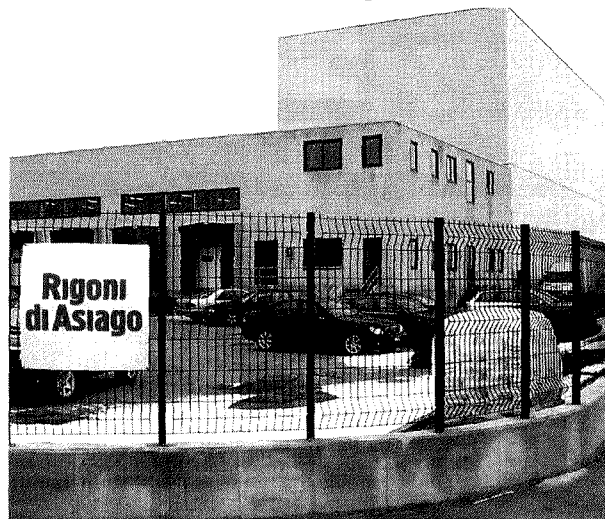
Il centro logistico Rigoni ad Albaredo: qui ci sarà il nuovo stabilimento
